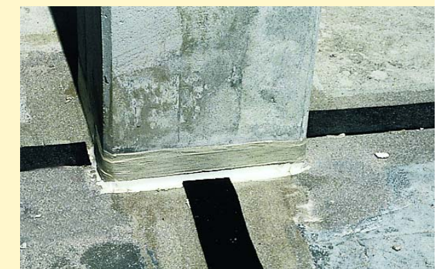
Пример: Компенсационные швы между стеной и полом в промышленных полах
