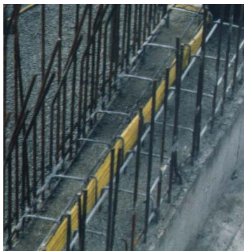
вспомогательные элементы из арматуры для крепления гидрошпонок
