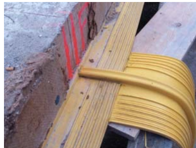
■ пример угловой стыковки гидрошпонок
